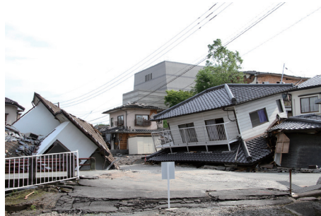
住宅被害（益城町）（提供 熊本県益城町）
