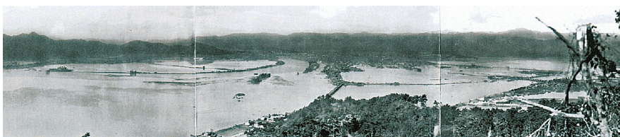
1946年の南海地震後 (地盤が1.15m沈下)
