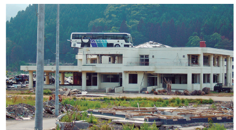
大津波によってビルの屋上に運ばれた観光バス (平成23年7月15日の宮城県石巻市)
