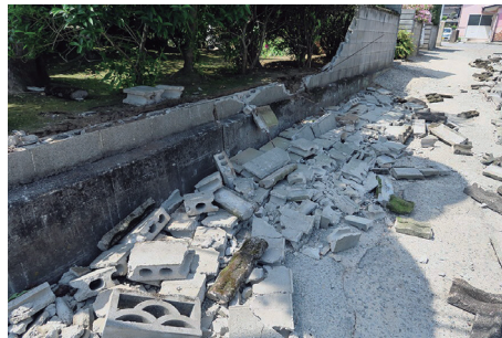
ブロック塀倒壊（提供 防災システム研究所）
