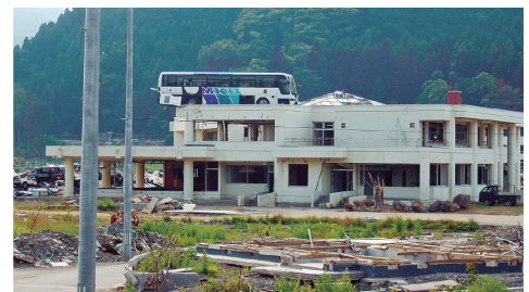
Bus pariwisata yang berada di atas gedung karena tsunami besar (Ishinomaki, Miyagi. 15 Juli 2011)
