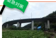
国道195号 山崎陸橋
