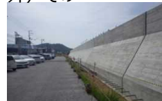
海岸堤防の耐震補強状況
