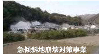
急傾斜地崩壊対策事業
