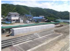
海岸堤防の耐震補強状況
