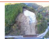
安田東洋線（安田町平瀬地区）
