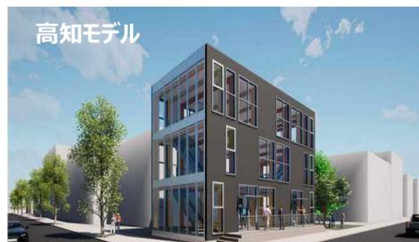
※高知モデルとは、県内製材工場が県産材で製材したラミナを用いて製造した集成材をラメンフレームに使用した3～4階建て木造建築物
