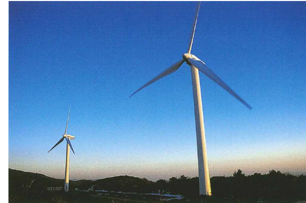
甫喜ヶ峰風力発電所
