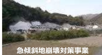
急傾斜地崩壊対策事業
