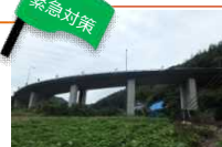
国道195号 山崎陸橋
