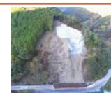
安田東洋線（安田町平瀬地区）
