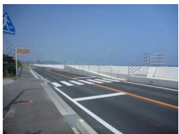
海岸堤防の耐震補強状況
