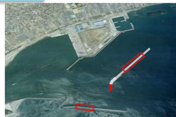
高知港防波堤の整備
