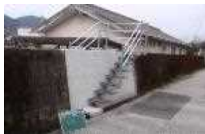
コンクリートによる陸こうの閉鎖
