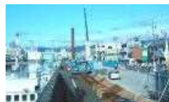
海岸堤防の耐震補強状況
