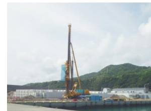
防災拠点漁港の岸壁耐震化
