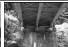
橋梁の 耐震補強
