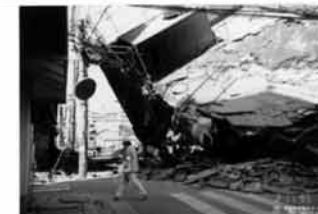
【倒壊した建築物による道路の閉塞状況】
