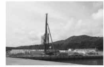
防災拠点漁港の岸壁耐震化
