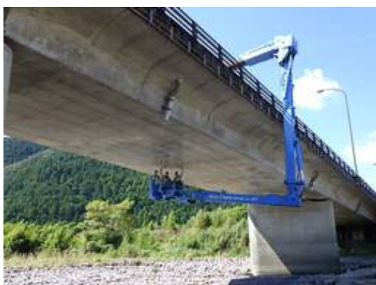
従来の点検方法（橋梁点検車点検）
