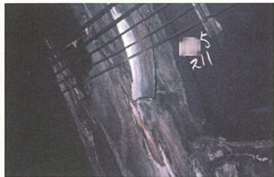
写真 1.10 補修モルタルが劣化してはく離している例（P.40 文献 2) 参照）
