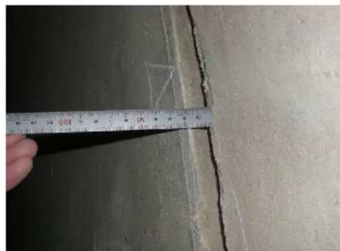
図 1.14 目地部、打継ぎ目部の段差の例
