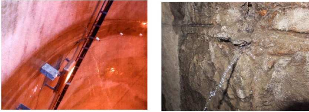
写真 1.8 漏水（噴出）している例（P.40 文献 2) 参照）
