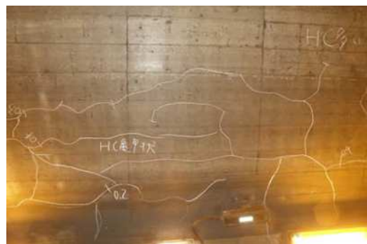
写真 1.6 複数のひび割れで覆工コンクリートがブロック化している例（P.40 文献 2) 参照）
