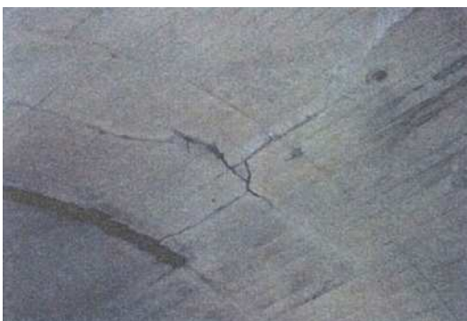
写真 1.6 複数のひび割れで覆工コンクリートがブロック化している例（P.40 文献 2) 参照）
