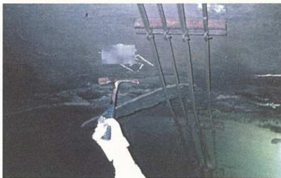
写真 1.10 補修モルタルが劣化してはく離している例（P.40 文献 2) 参照）
