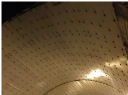
写真 1.11 鋼板接着；左・繊維シートの接着；右の例（P.40 文献 2) 参照）
