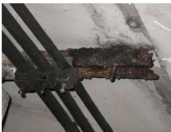
図 2.3 固定金具の腐食とアンカーボルトの脱落の例（巻末資料 P1-43 文献 1) 参照）
