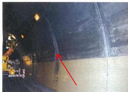
図 1.9 覆工スパンの中間付近に発生する変状の例（P.40 文献 2) 参照）
