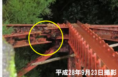
終点側（北川村）下流側の破断面
