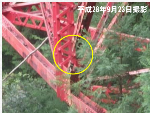
終点側（北川村）下流側の 斜材破断状況の拡大写真
