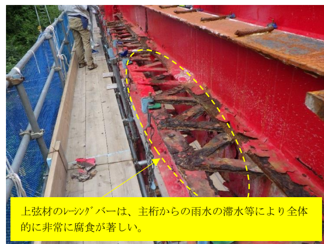
上弦材の腐食状況
