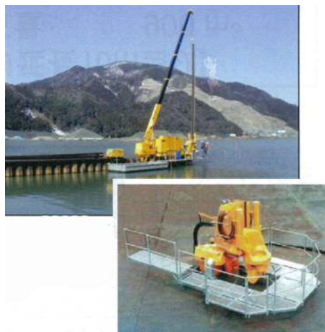
鋼矢板の圧入工法
