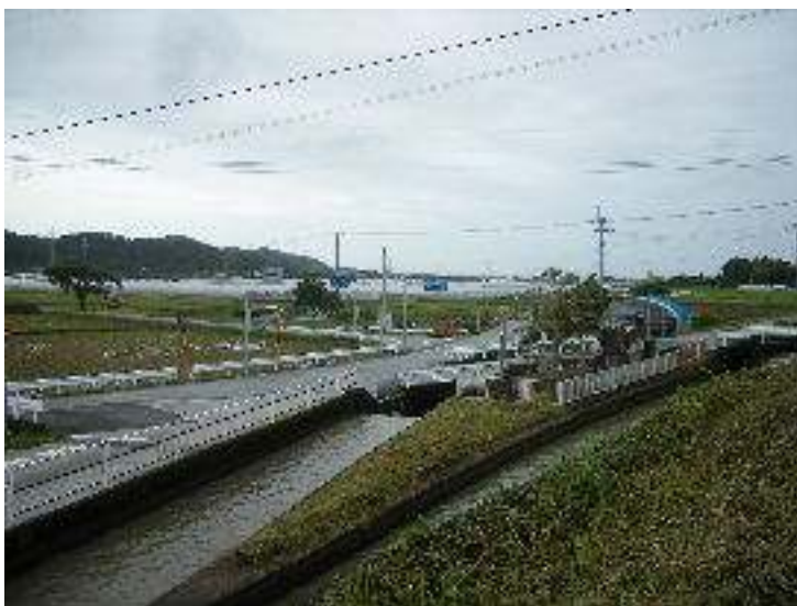
5月21日 山田分水工 舟入井筋と中井筋の間の空地
