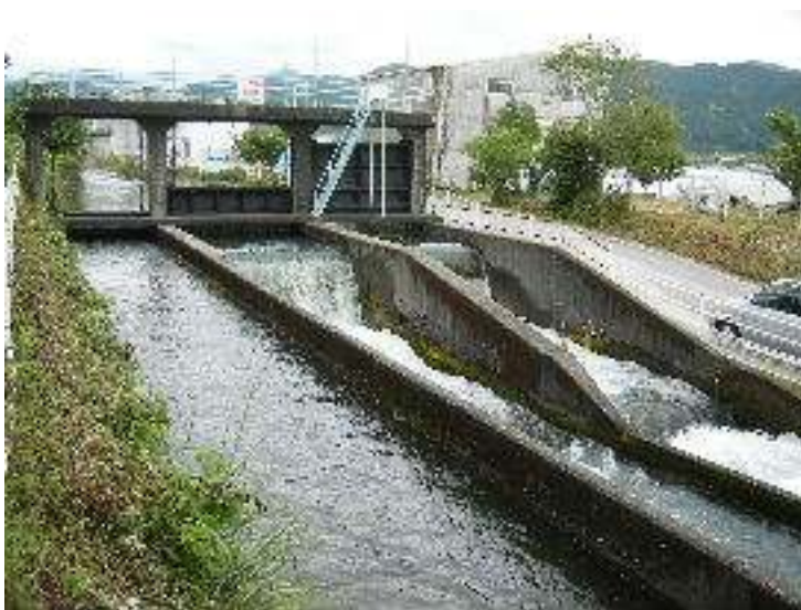
5月21日 山田分水工 水門付近の落差工
