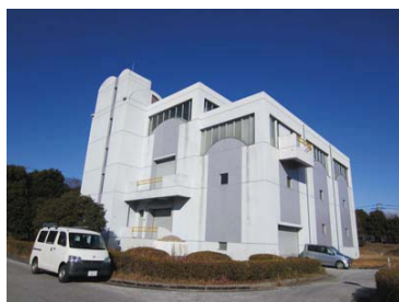
5. 機械濃縮棟 (全景・屋根)
