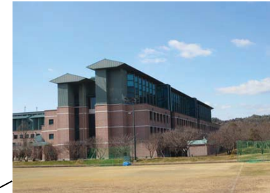
3. 教育研究棟 B (全景・屋根)
