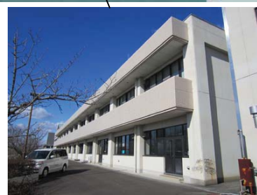
3. 実験棟 (C棟) (全景)
