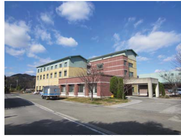
7. 地域連携棟 (全景・屋根)
