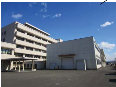
4. 機械実験棟 (E棟) (全景)
