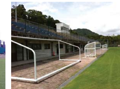
7. 球技場スタンド棟 (全景)
