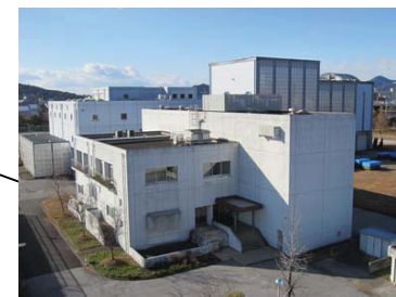
4. 汚泥処理棟 (全景・屋根)
