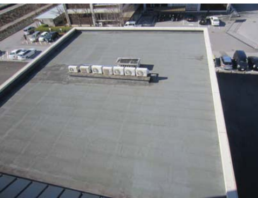
6. 計量検定所 (G棟) (屋根)
