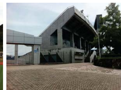
3. 陸上競技場サブスタンド (全景)
