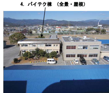
4. バイテク棟 (全景・屋根)
