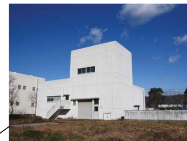
3. ポンプ棟 (全景)
