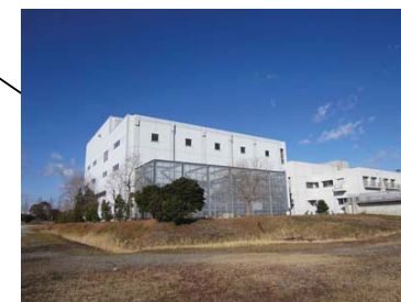
6. 焼却補機棟 (全景)
