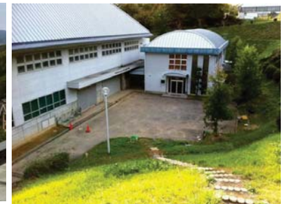
12. 屋内運動場 附属棟 (全景)
