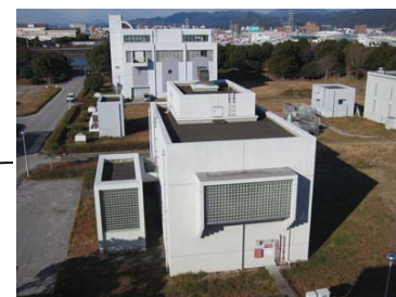
8. 電気棟 (全景・屋根)
