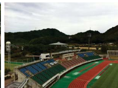
2. 陸上競技場メインスタンド (全景)
