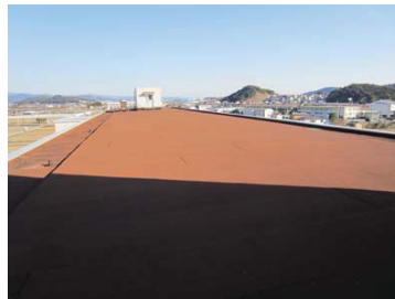
5. 校舎棟 (南校舎・西棟) (屋根)
