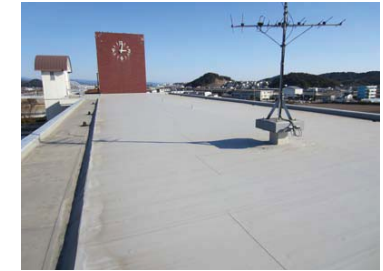
7. 校舎棟 (南校舎・東棟) (屋根)
