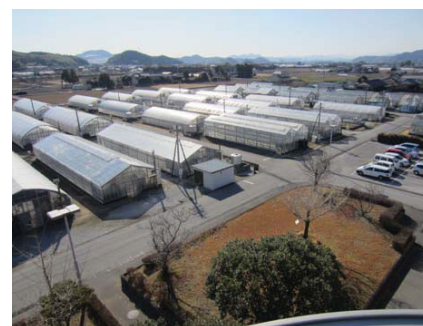
20. ビニールハウス (全景・屋根)
