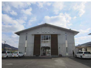
2. 商品化研究棟 (A棟)
