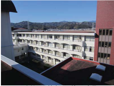
1. 本館 (北校舎・西棟) (全景)
