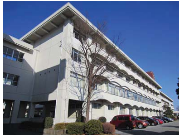
5. 校舎棟 (南校舎・西棟) (全景)
