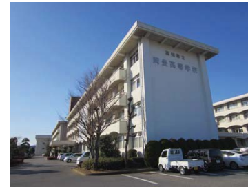
7. 校舎棟 (南校舎・東棟) (全景)
