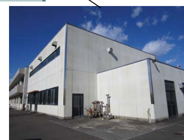
5. 材料実験棟 (F棟) (全景)
