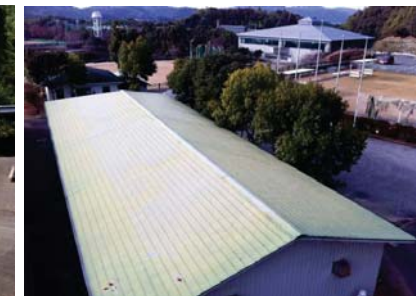
16. ビームライフル場 管理棟 (屋根)
