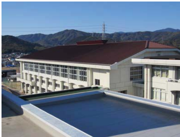
13. 体育館 (その他) (屋根)
