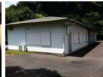
16. ビームライフル場管理棟 (全景)
