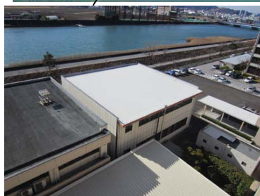
4. 機械実験棟 (E棟) (屋根)
