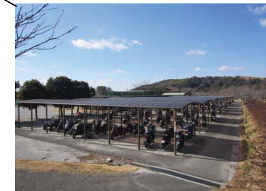
11. 駐輪場 (全景・屋根)
