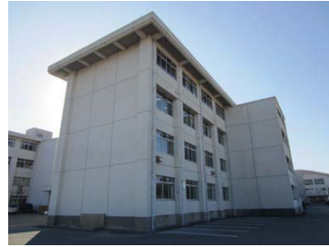
3. 校舎棟 (北校舎・東棟) (全景)
