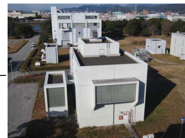
8. 電気棟 (全景・屋根)
