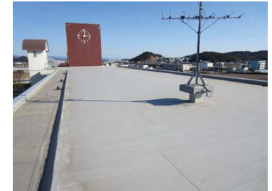
7. 校舎棟 (南校舎・東棟) (屋根)
