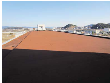
5. 校舎棟 (南校舎・西棟) (屋根)
