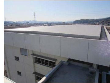
9. 多目的棟 (その他) (屋根)
