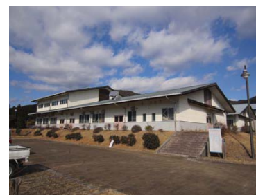
4. 材料強度・構法・構造関係実験棟 (C棟)
