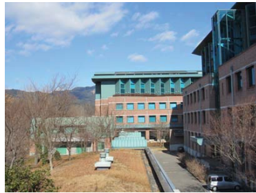
4. 教育研究棟 C (全景・屋根)
