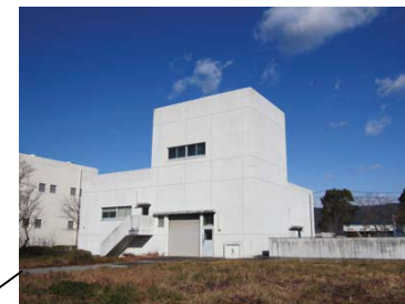
3. ポンプ棟 (全景)
