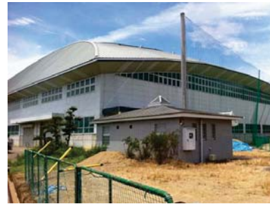
11. 屋内運動場 (全景)
