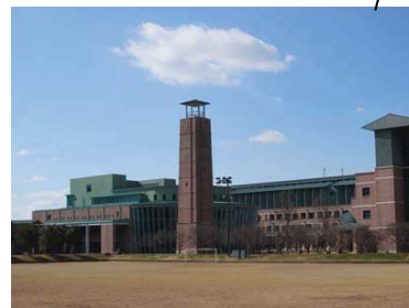
1. 本館 (全景・屋根)
