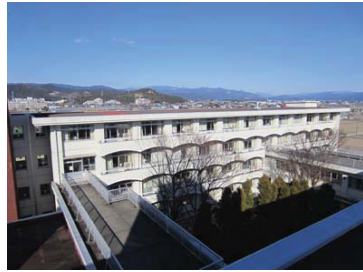
3. 校舎棟 (北校舎・東棟) (屋根)
