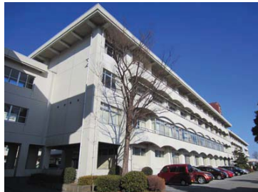
5. 校舎棟 (南校舎・西棟) (全景)
