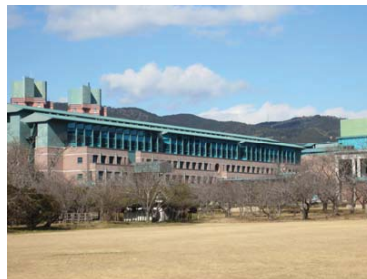
2. 教育研究棟 A (全景・屋根)
