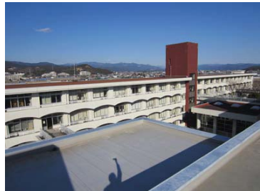
6. 昇降所 (南校舎・西棟) (屋根)
