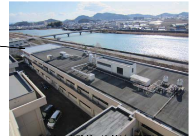
3. 実験棟 (C棟) (屋根)
