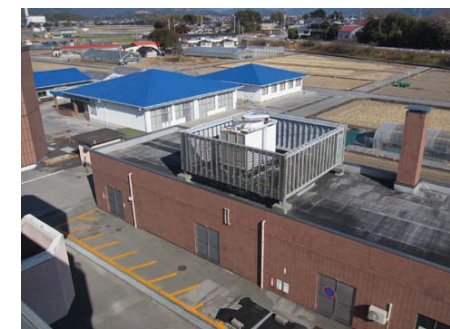
3. 機械室棟 (屋根)
