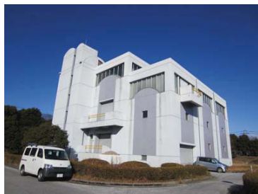
5. 機械濃縮棟 (全景・屋根)
