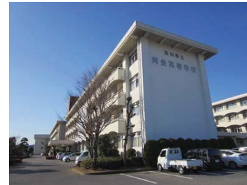
7. 校舎棟 (南校舎・東棟) (全景)
