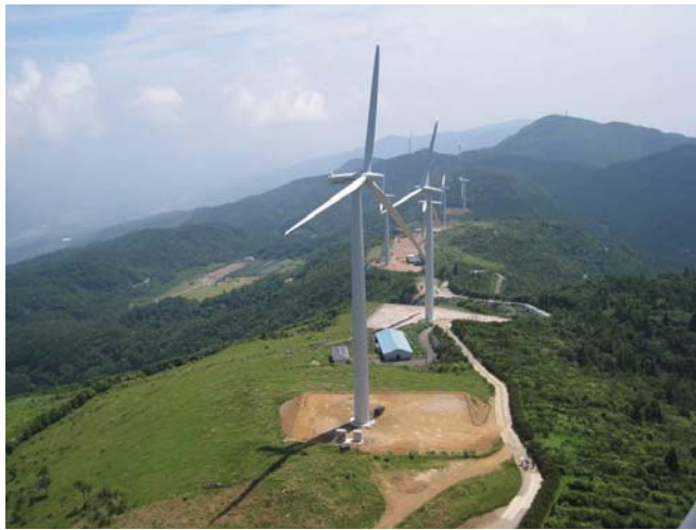
写真 5-1：敷地造成の事例（徳島県大川原ウインドファーム）
