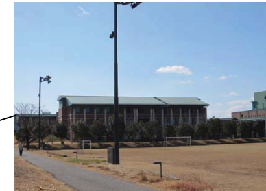
8. 講義棟 (全景・屋根)
