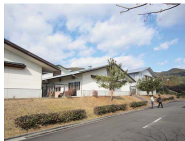
3. 材料環境関係実験棟 (B棟)
