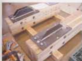
□集成材に取付けたプレート グラウトは注入容量管理を行う。ボルト間の穴より注入し反対側の穴より出てくるのを確認する (上)
