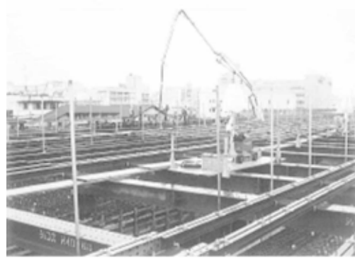
梁スラブコンクリート打設
