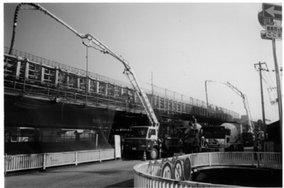
コンクリート打設状況
