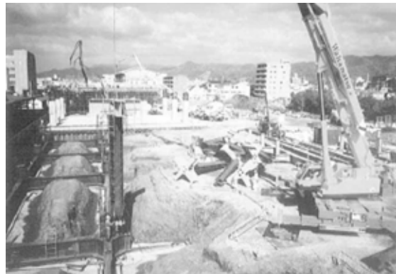
地中梁型枠組立完了
