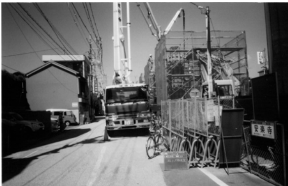
高架柱コンクリート打設状況
