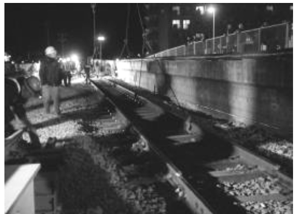
起点方線路移設状況
