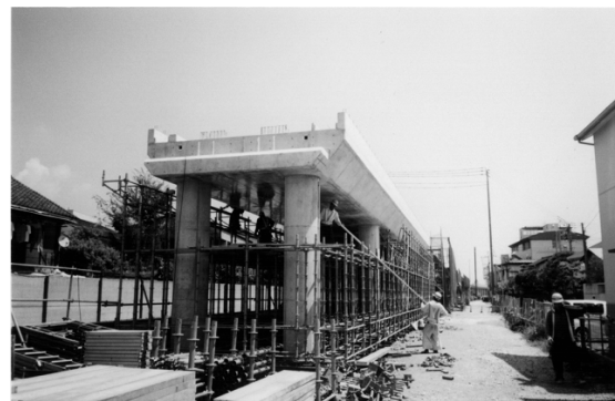
高架橋完成状況
