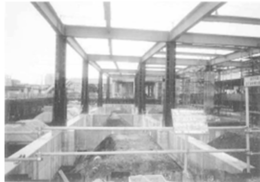
地中梁コンクリート出来形
