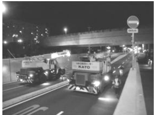
起点方周辺道路状況
