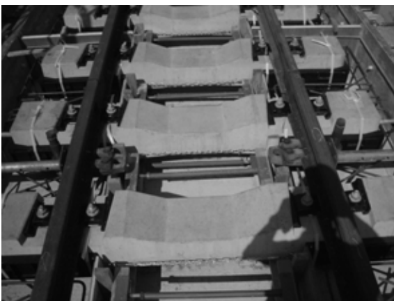
内型枠固定梁
