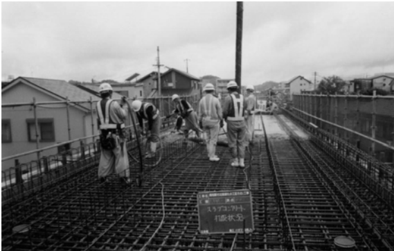
スラブコンクリート打設状況
