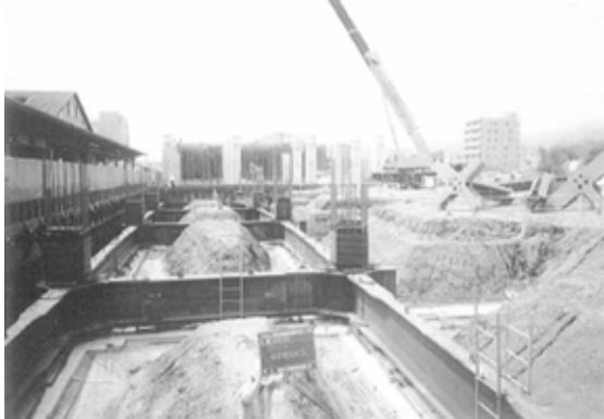
地中梁鉄骨建方
