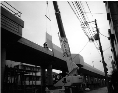
高欄パネル吊り上げ状況
