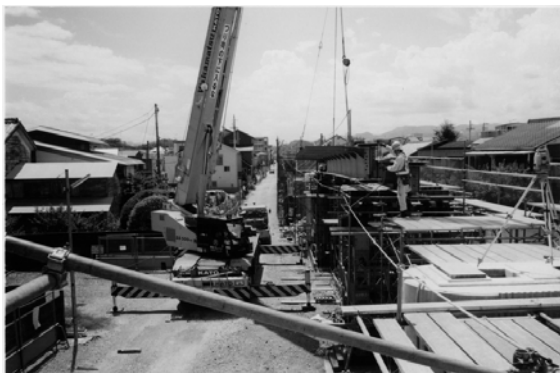
主桁架設状況
