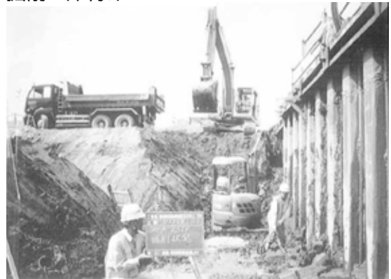
掘削・床付け
