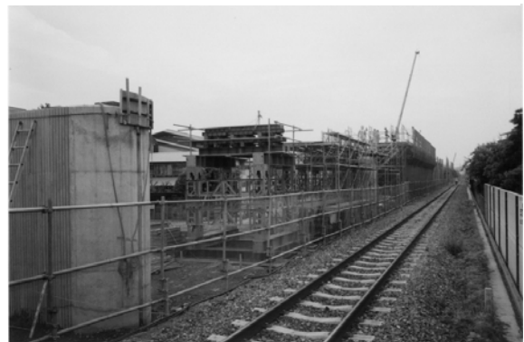
H鋼埋込桁 主桁架設ベント組立完了状況
