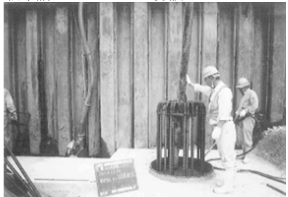
杭中詰めコンクリート打設
