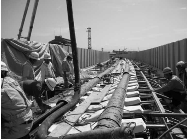
道床コンクリート打設状況
