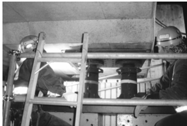
PC桁 ジャッキアップ施工
