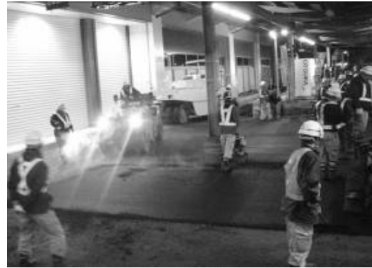
切替当夜作業状況(高知駅部)
