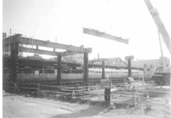
上層梁鉄骨建方
