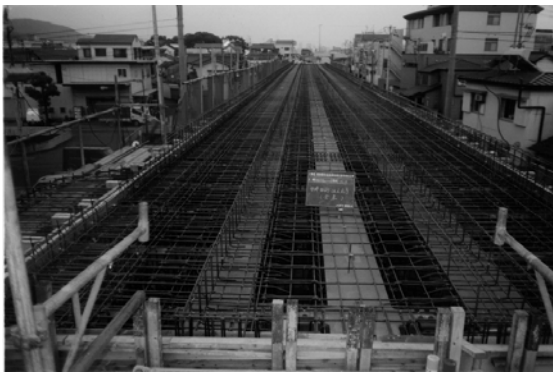
鉄筋、型枠組立完了状況
