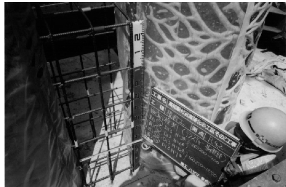
下部テクスチャー鉄筋組立状況
