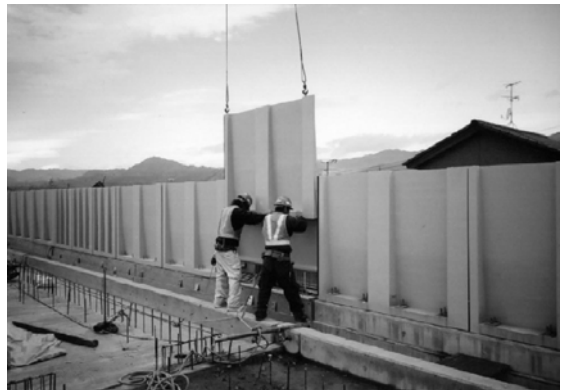
高欄パネル建て込み状況
