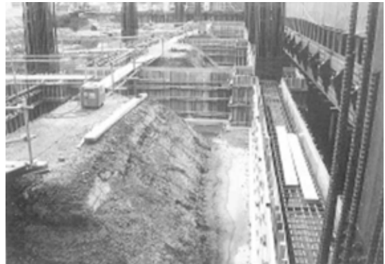
地中梁型枠組立完了
