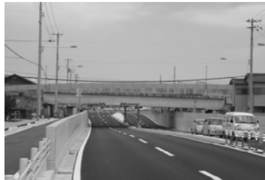
起点方切替部 PC 桁側面
