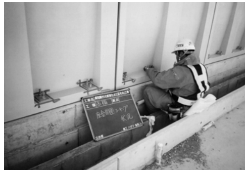
コーキング施工状況
