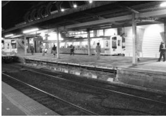
既設ホーム撤去後の仮復旧ホーム(高知駅)
