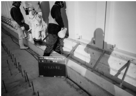
グラウト注入
