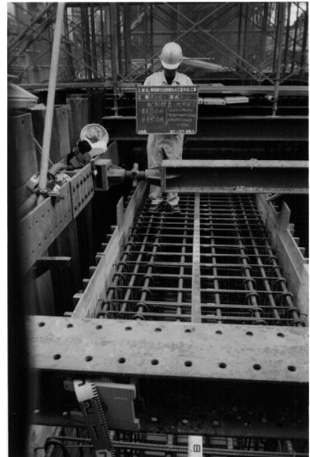
フーチング鉄筋、型枠組立完了状況
