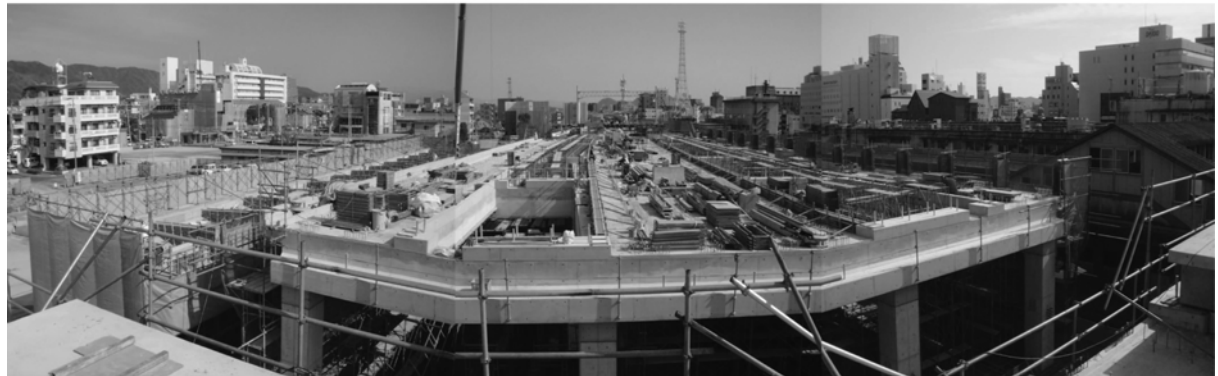
SRC-A 高架橋完成
