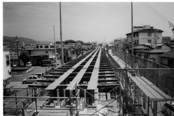
H鋼埋込桁架設完了状況
