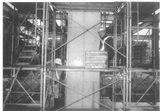
柱コンクリート出来形
