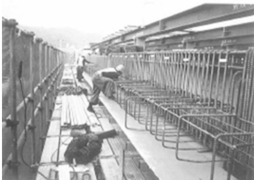
上層梁鉄筋組立
