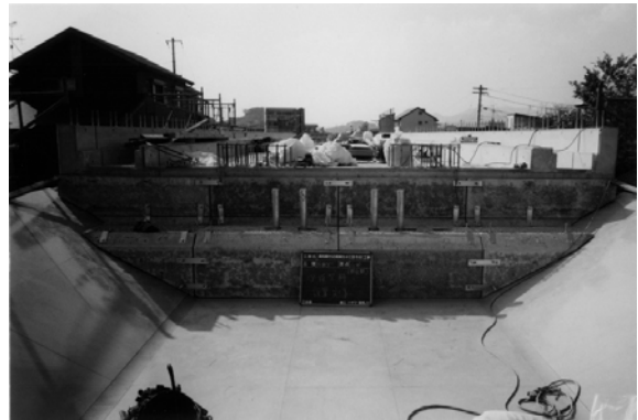
埋設型枠組立完了状況
