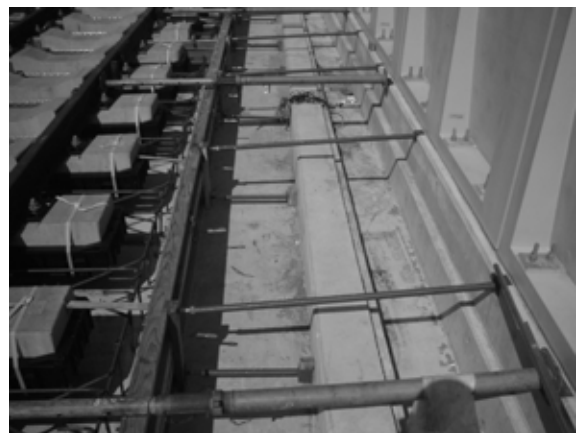
外型枠固定梁
