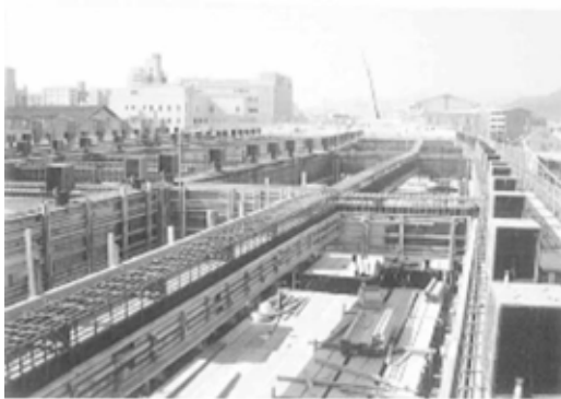
上層梁型枠組立完了
