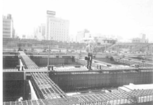
上層梁鉄筋組立完了
