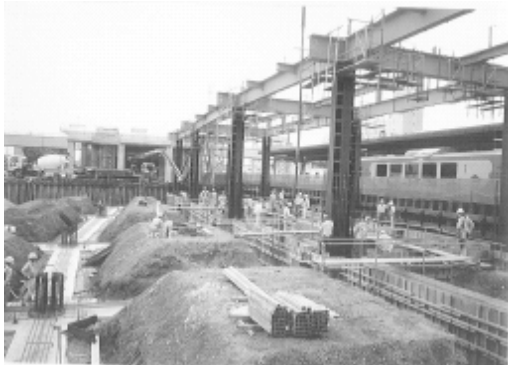
地中梁コンクリート打設
