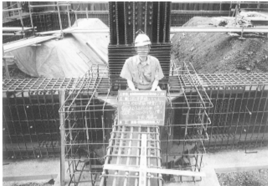
地中梁鉄筋組立
