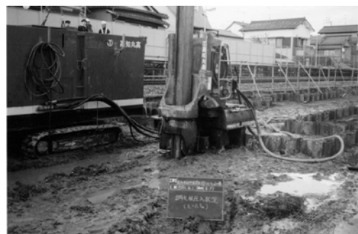
鋼矢板打設状況
