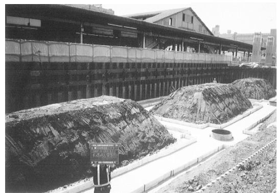
均しコンクリート打設完了
