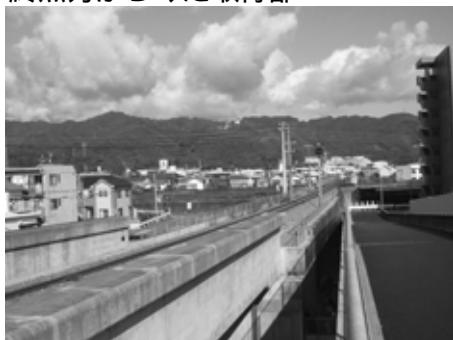
終点方からみた取付部
