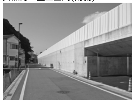
終点方の盛土区間(南側)
