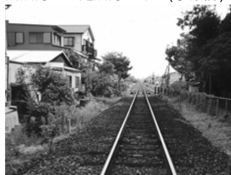
終点方から起点方を見る(事業前)
