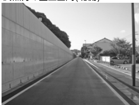
終点方の盛土区間(北側)
