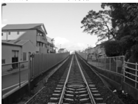
終点方からみた取付部
