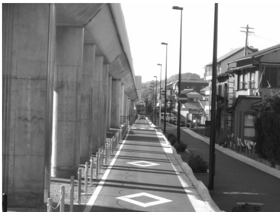
チェーンで区切られた高架下の様子
