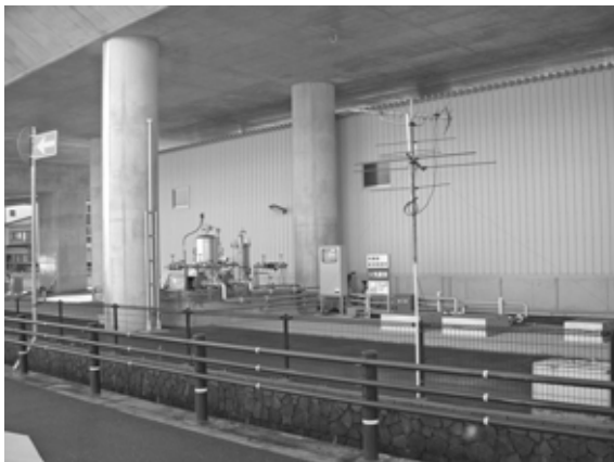
中間部の高架下利用 給油施設等
