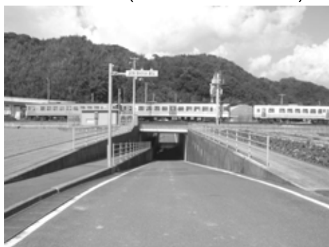
ルート4 道路(大切踏切地下道化)
