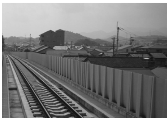
遮音壁の設置状況
