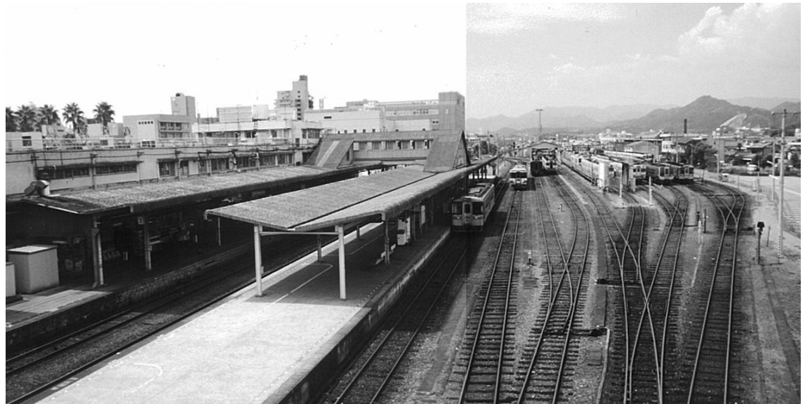
事業前の高知駅構内 (左側が旅客ホーム、正面～右側が車両基地)
