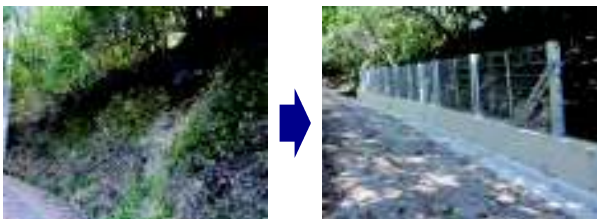
避難経路や避難場所背後の危険な斜面の安全対策
