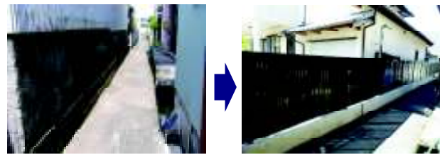
危険なブロック塀を生け垣や柵に変更し被害を未然に防止
