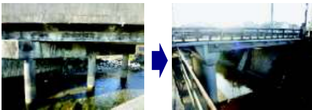
避難が集中する橋梁の耐震補強の実施
