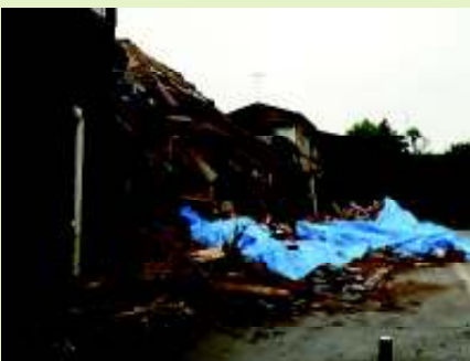
古い家屋の倒壊
