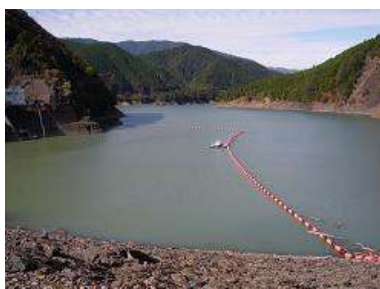
・魚梁瀬ダムの風景
