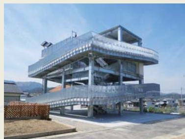
津波避難タワー (四万十市)
