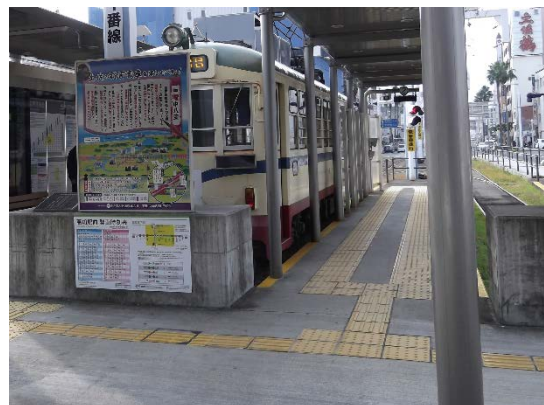
駅構内のフラット化 (とさでん交通高知駅前電停)
