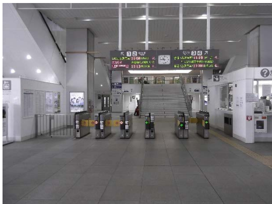
駅構内のフラット化 (JR高知駅改札)
