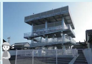
津波避難タワー
