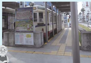
駅構内のフラット化 (とさでん交通高知駅前電停)
