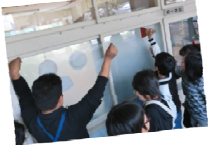
ガラス飛散防止フィルム張り
