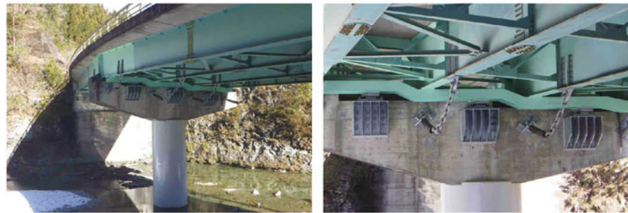
国道194号 根来1号橋(いの町)
