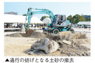
▲通行の妨げとなる土砂の撤去
