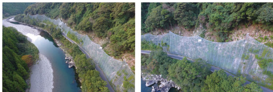
国道493号(安芸郡北川村)
