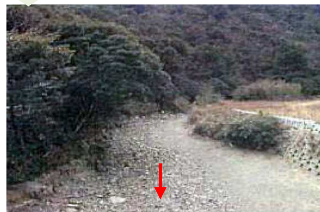
渇水期: 河川が枯渇し正常な機能が失われる 中小路頭首工上流部 [H16.2]
