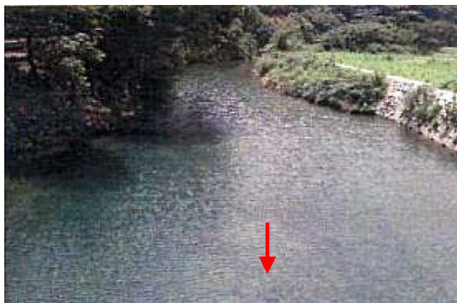
通常期: 河川に水が流れている 中小路頭首工上流部 [H15.7]
