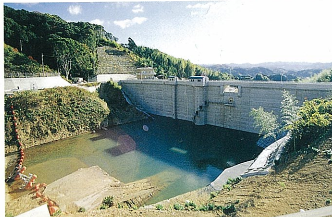
試験湛水状況（H7. 11月）
