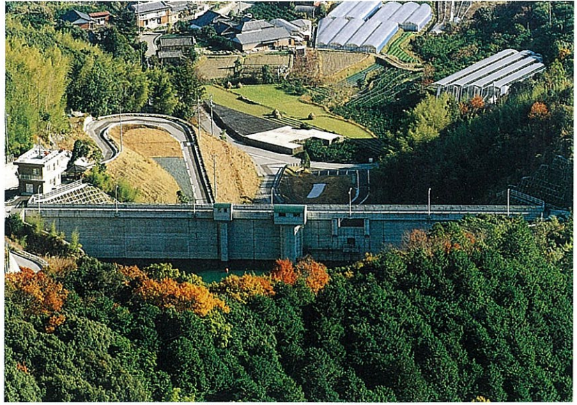
ダム全景(上流より)
