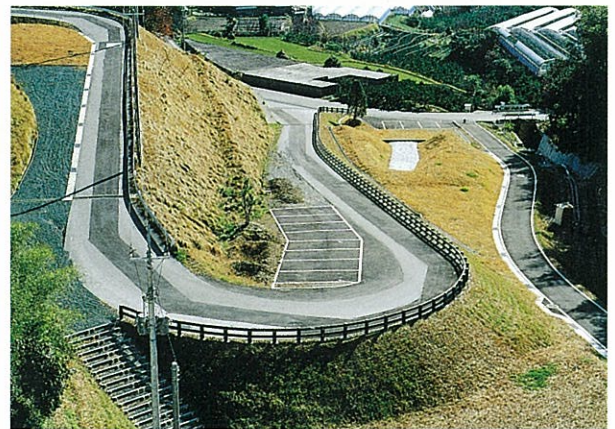
ダム下流広場
