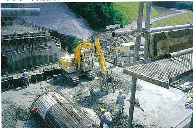
コンクリート打設状況
