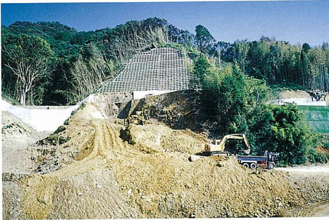
左岸堀削状況
