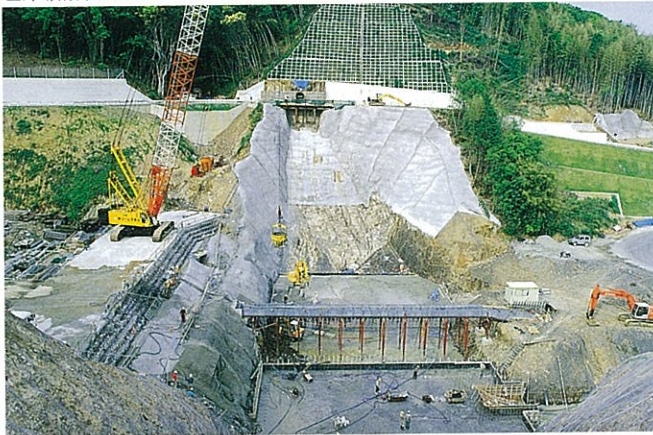
コンクリート打設状況（H6. 4月）
