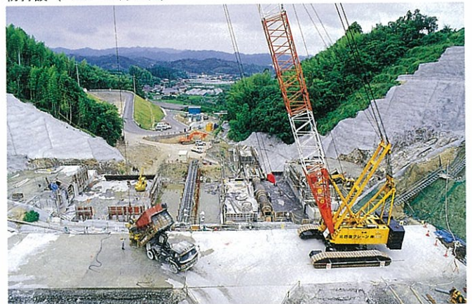
コンクリート打設状況（H6. 6月）
