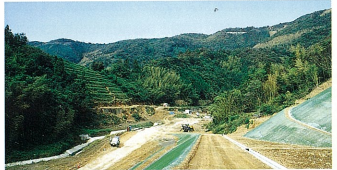
ダムサイト着手前(下流より)
