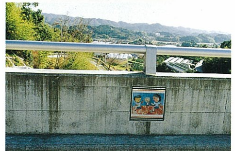
天端道路高欄壁
