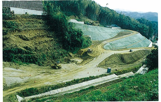
ダムサイト着手前（上流より）
