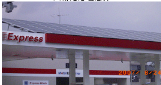
太陽光発電施設
