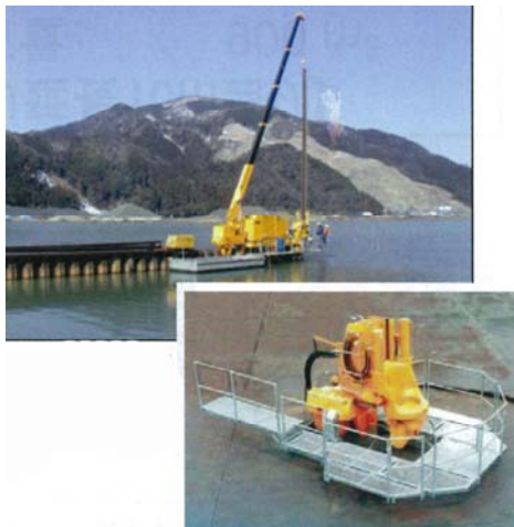
鋼矢板の圧入工法
