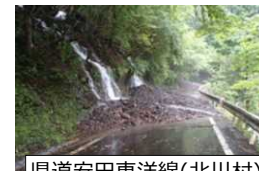
県道安田東洋線(北川村)
