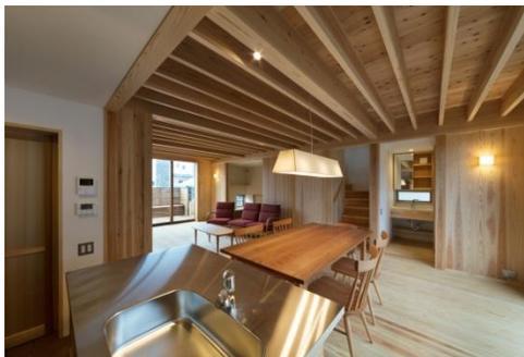
この建物は、平成29年3月に竣工された、木造2階建て個人住宅であり、SWP(シングルウッドパネル)という県産材を使用した新しい建材を高知県内の住宅では初めて採用し、壁、2階の床組に使用しています。SWPには施主様の希望により、嶺北の杉を使用。このSWPを用いた空間が南の庭からウッドデッキテラス、リビングダイニングを通り、北の庭に抜けるような、まさに「木のトンネル」空間を実現しています。
