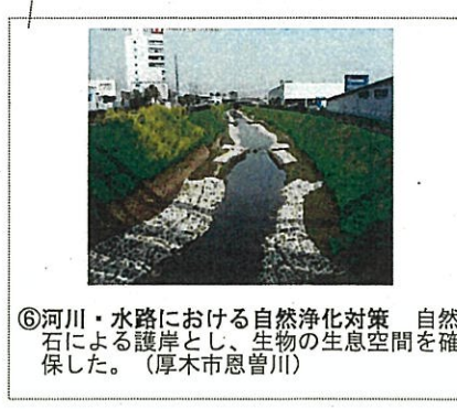
⑥河川・水路における自然浄化対策 自然石による護岸とし、生物の生息空間を確保した。(厚木市恩曾川)
