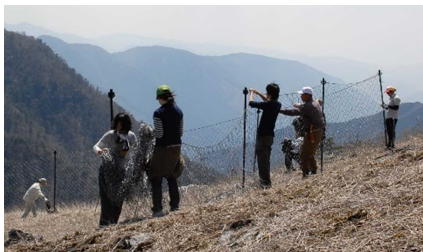
防鹿柵の設置
