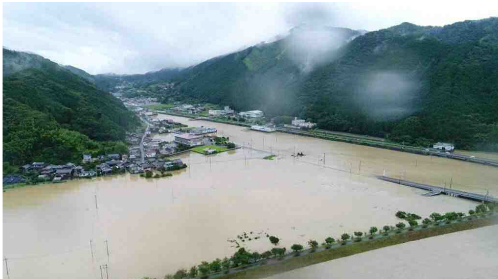
和田地区県道の浸水
