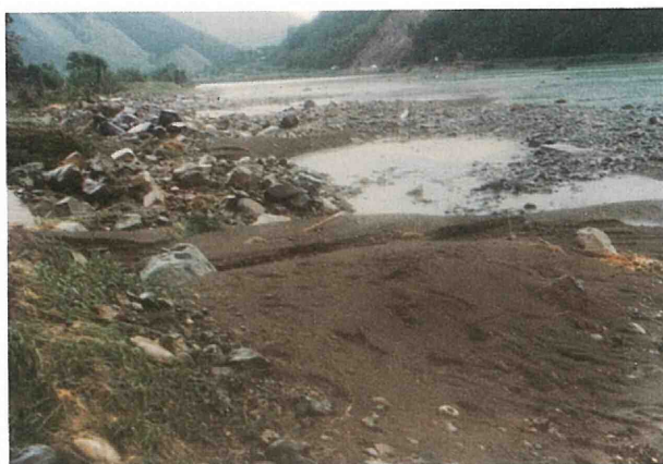
橋上地区右岸堤防の決壊
