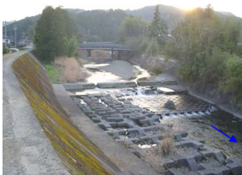
道の川合流点付近より上流の整備状況 （大新改頭首工付近：河口から1.3km地点）
