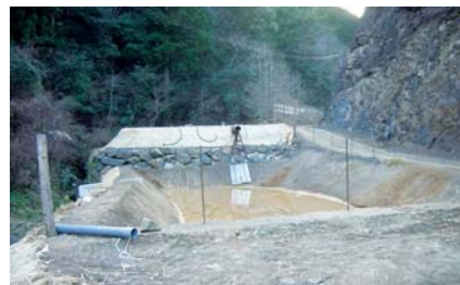
工事完了後の沈砂池のイメージ
