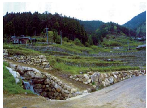
棚田の石垣を保全した例
