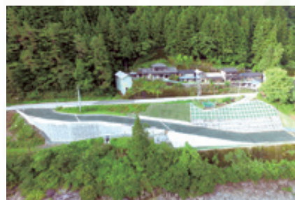
早明浦ダム貯水池進入路整備工事
