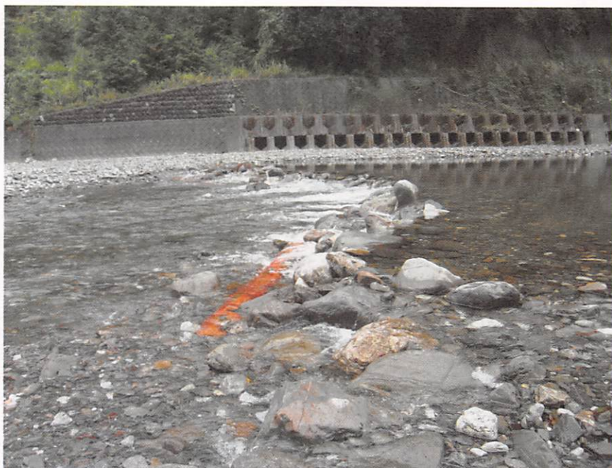
図5 左岸から見たⅠ型構造物と流況 (H17. 8. 23) (左岸に構造物下流側最上段の木材が見える)
