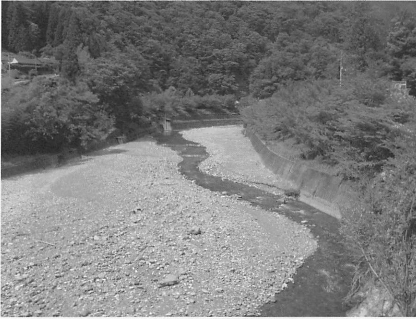
図3 構造物設置・調査区域の河川概況 (H17.6.6) (図2のNo.3ライン国道上からの写真)
