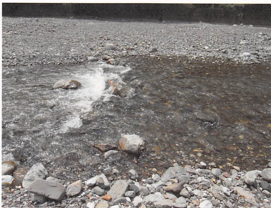
図6 左岸から見たⅡ型構造物と流況 (H17. 6. 6)
