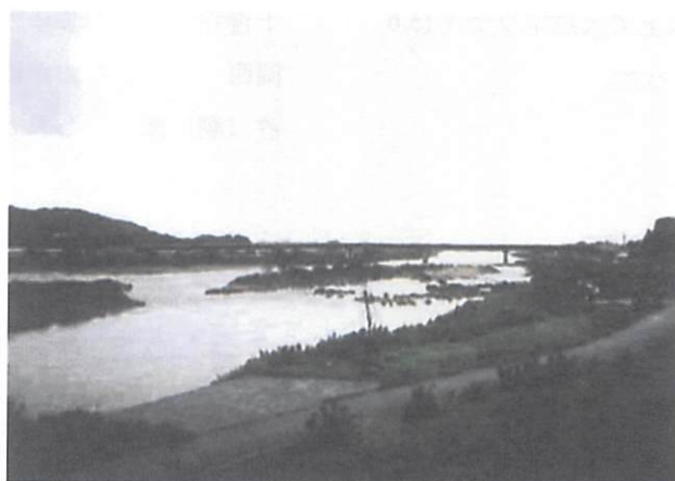
写真2 物部川戸板島橋 (洪水モード)
