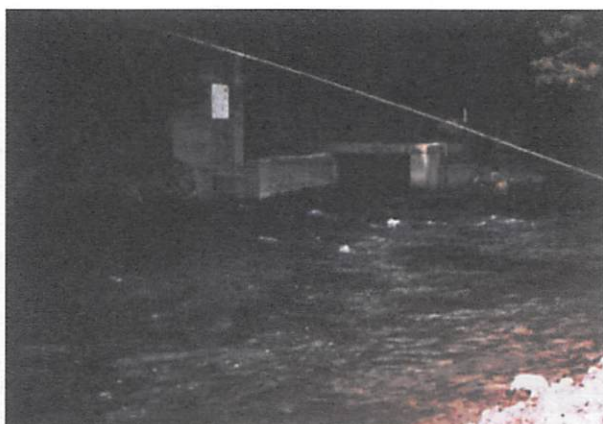
図1 伊尾木川ダム発電所放水口付近地形
