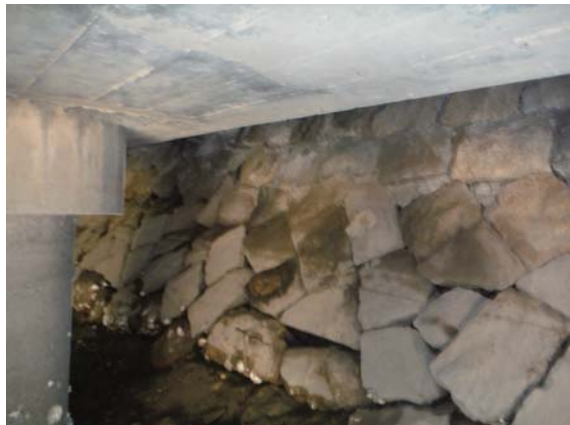
写真①石積護岸のはらみ状況
