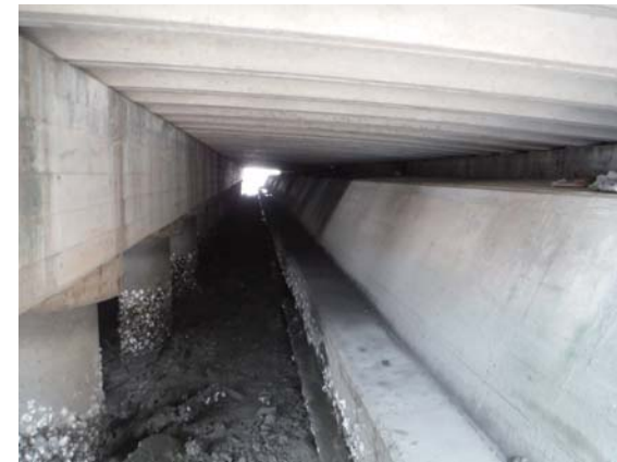
写真④コンクリート護岸区間
