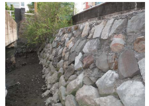
写真⑤コンクリート充填された石垣
