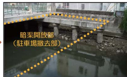
暗渠開放後（駐車場撤去後）
