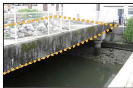
暗渠開放前（駐車場撤去前）
