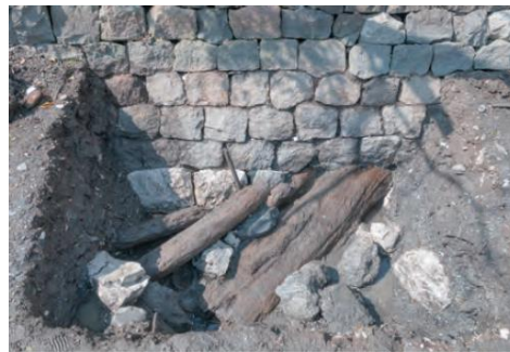
試掘により根入れ部で確認された木材
