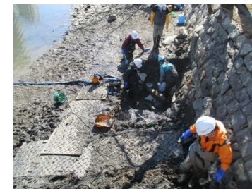
西岸石垣調査状況
