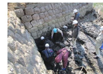
東岸石垣調査状況
