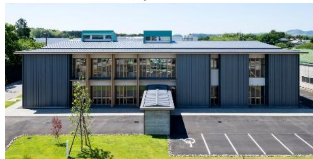
高知県森林組合連合会事務所（平成 28 年 3 月完成） （木造+CLT 2 階 延べ床面積 1,209 m 2 ）
