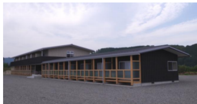
県立農業担い手育成センター長期研修用宿泊施設 （平成 28 年 4 月完成） （CLT 構造 延べ床面積 724 m 2 ）
