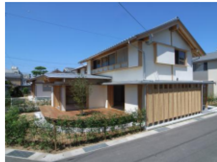
木造住宅 (外観)
