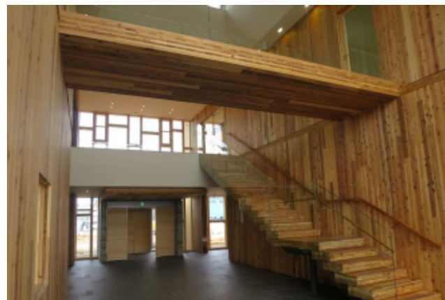
高知県森林組合連合会事務所（内部エントランス）
