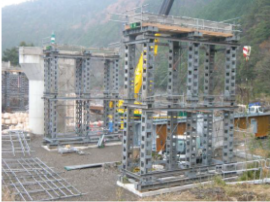
(写真1) 栲原川を極力乱さない架設工法を採用 (河原を掘削しない場所打コンクリート基礎)
