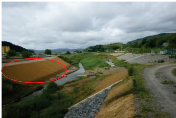
（写真7）覆土状況
