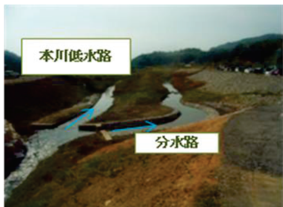
（写真8）低水路状況
