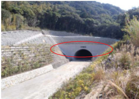
(写真3) トンネル坑口のポット苗による緑化
