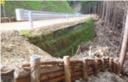
(写真8)補強土壁工による緑化
