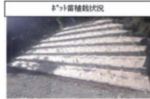
(写真3) トンネル坑口のポット苗による緑化
