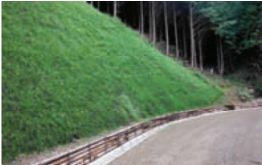
(写真7)野生動物忌避剤を混入した緑化法面
