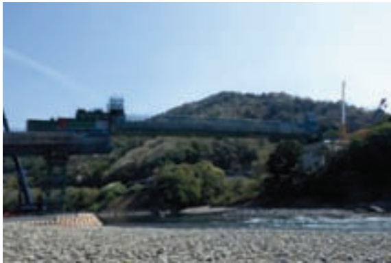
(写真1) 四万十川を極力乱さない架設工法を採用
